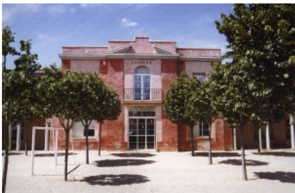
Edifici de les Escoles
