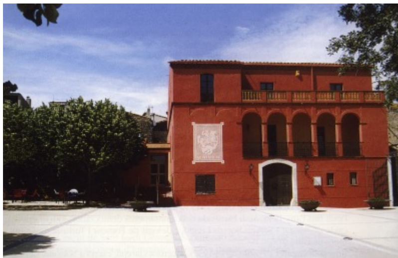
Edifici de "Can Miqueló" - Ajuntament de poble
